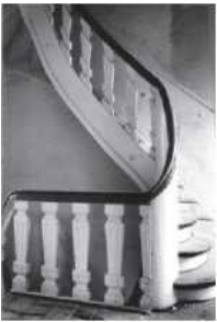
Cage d'escaliers historique Oberstraße 17, vers 1975
