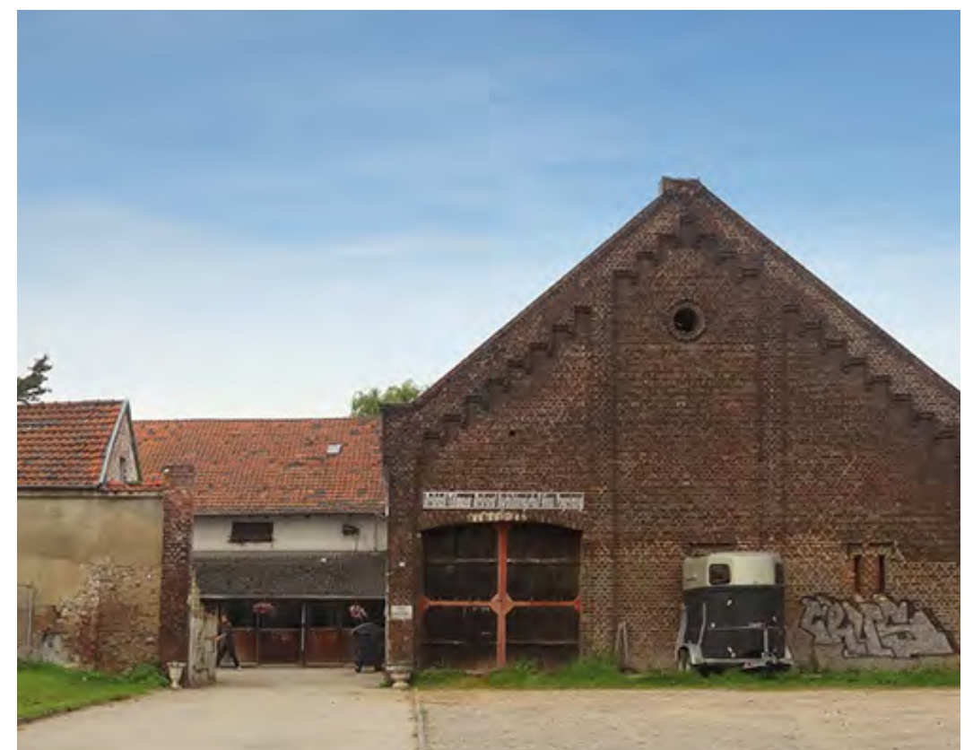
Les bâtiments agricoles restants peu de temps avant la démolition, 2016
