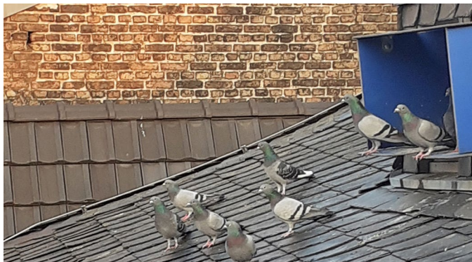
Taubenschlag Dachboden Rathaus
